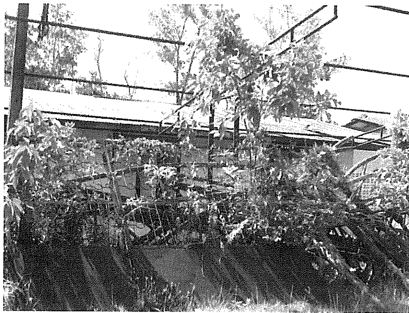
ภาพที่ ๒ โครงหลังคาเหล็กที่เอกล้อม
